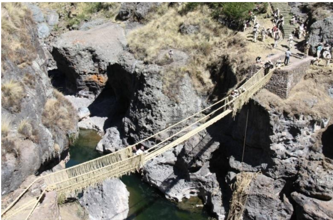
Figura 3. Puente Q'eshwachaka en proceso de reconstrucción, Cusco. Fuente: Ricardo Chirinos Portocarrero. Proyecto Qhapaq Ñan.
