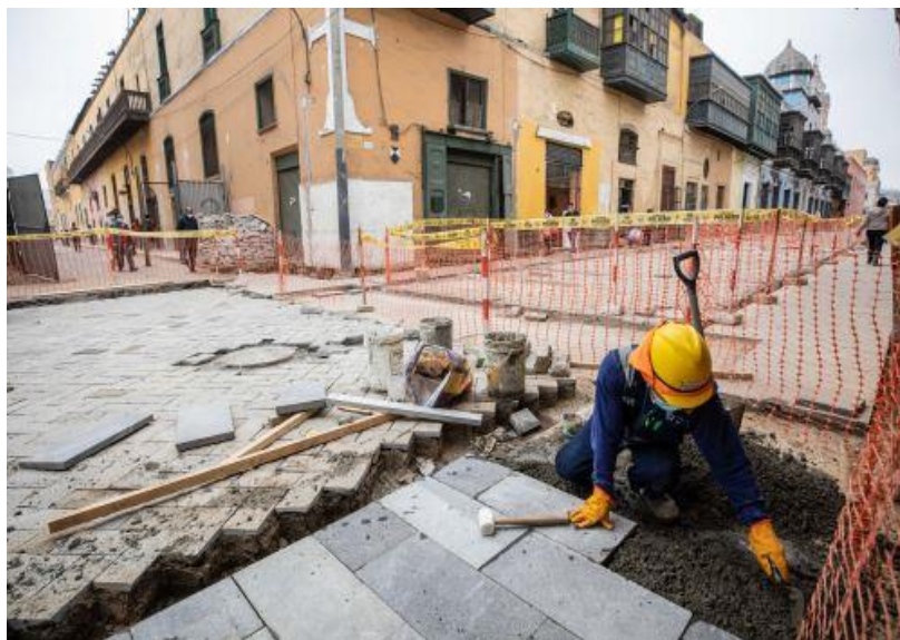
Las obras de peatonalización de 8 cuadras en el Damero de Pizarro se culminaron en el 2021.
