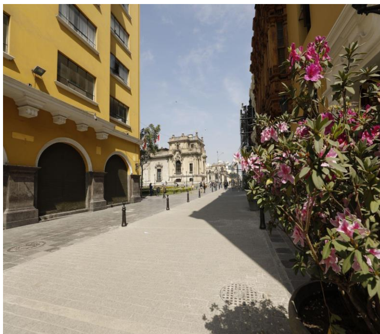
Cuadra 1 del jirón Conde de Superunda terminada.
