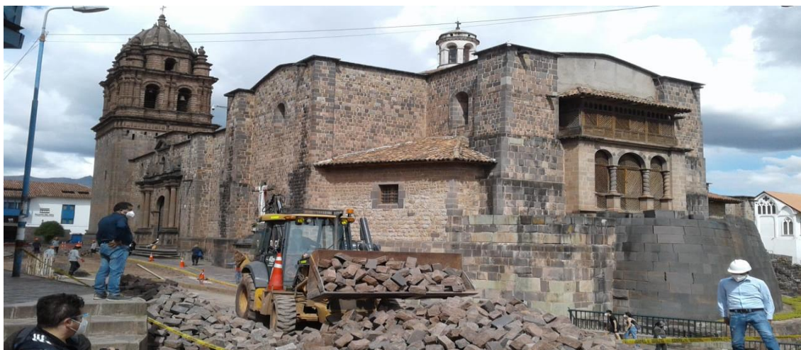
Figura 7. Cargador frontal sobre calzada de la calle Arrayan para mejora de la transitabilidad vehicular. Archivo fotográfico del Arq. Gonzalo Ortiz de Zevallos, 2021.
