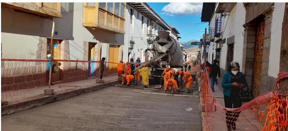
**Figura 4.** Mezcladora vertiendo concreto sobre calzada vehicular en la calle San Andrés. Archivo fotográfico del Arq. Gonzalo Ortiz de Zevallos, 2021
